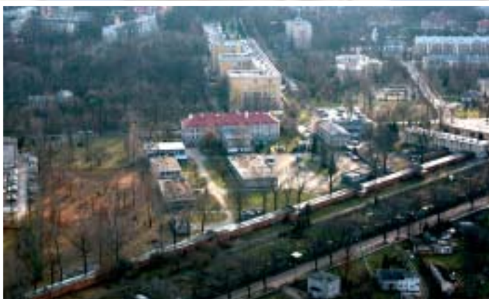
Strzelnica tunelowa – widok z lotu ptaka zdjęcie ze zbiorów Akademii Obrony Narodowej
