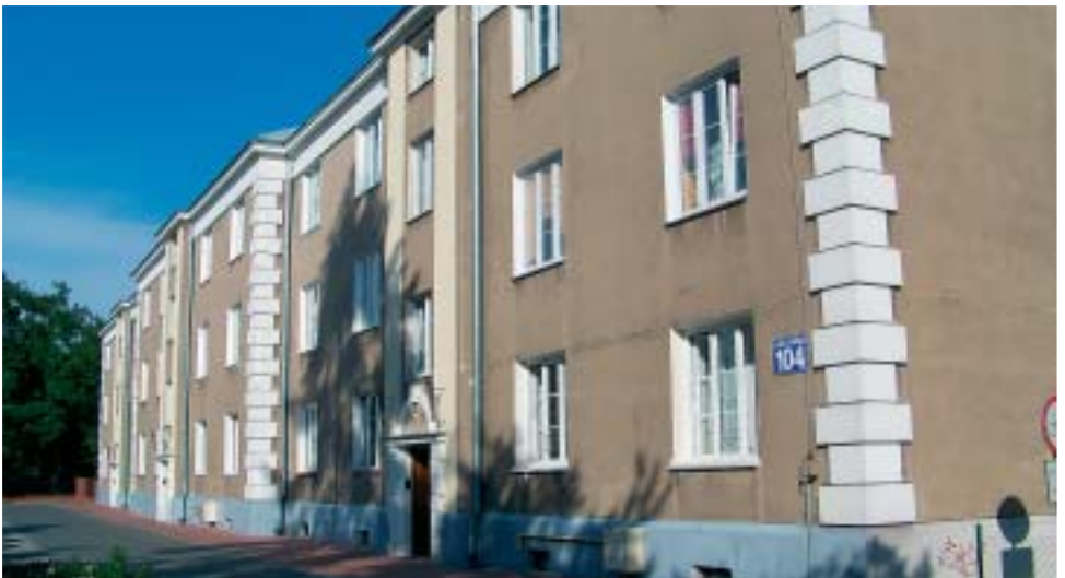
2012 r. Budynek mieszkalny w al. gen. A. Chruściela 104 zdjęcie Maciej Sulikowski
