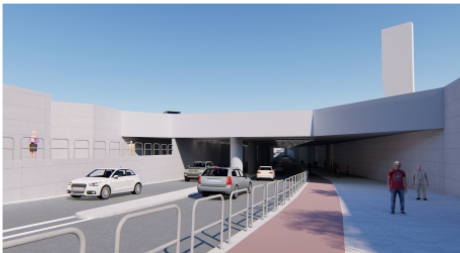
Portal tunelu od strony ul. Marsa. Pasy ruchu rozdzielone ze względu na słupy podtrzymujące strop tunelu. Chodnik po lewej stronie prowadzi do istniejącego przejścia podziemnego dla pieszych, które jest mniej zagłębione niż jezdnia.
